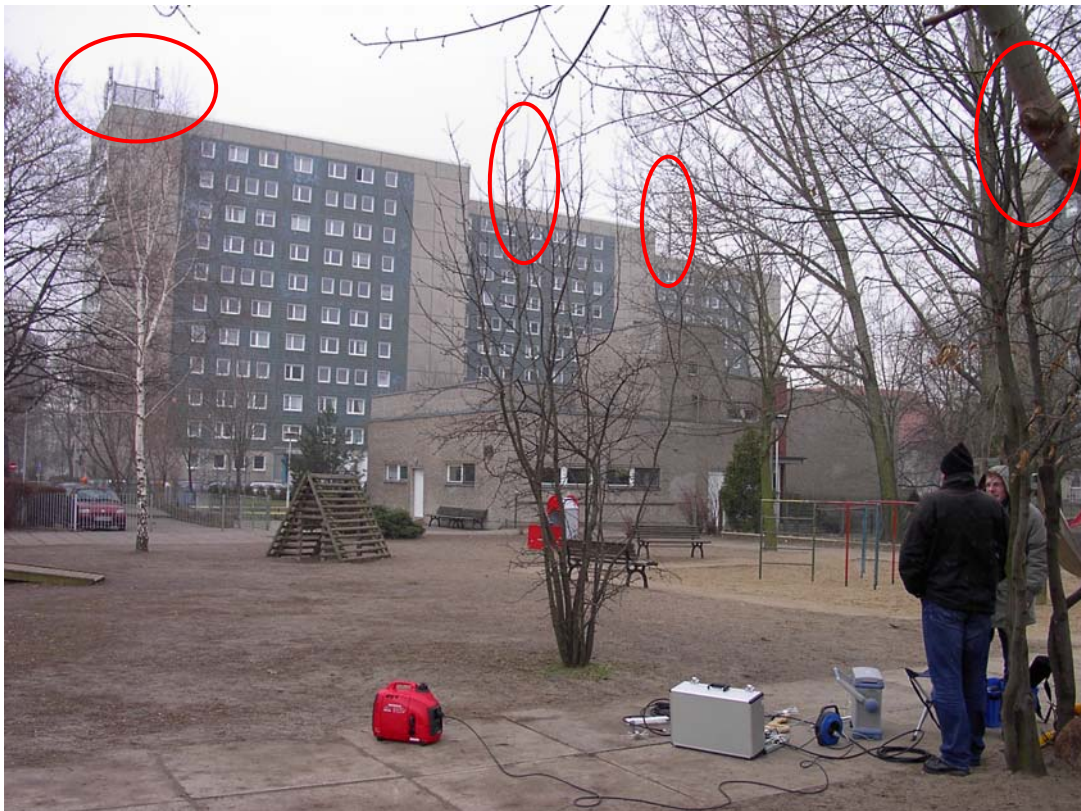
Abb. 7.11: Außenbereich von zwei Kindertagesstätten, umgeben von sechs Mobilfunkanlagen, deren Antennen auf den Dächern von vier benachbarten Hochhäusern montiert sind.
