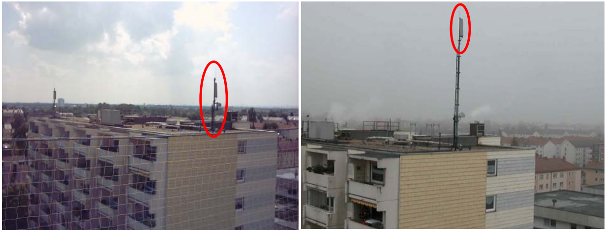
Abb. 7.20: Antennenstandort (links vor und rechts nach der Optimierung) vom kritischen Immissionspunkt aus gesehen.
