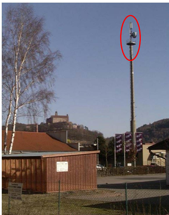
Abb. 7.9: Günstig: "Hoher" Antennenstandort bei gleichzeitig niedriger Umgebungsbebauung.
