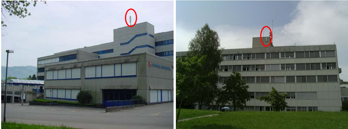
Abb. 7.5: Mobilfunkantennen, montiert auf einer Schule (links) bzw. auf einem Krankenhaus (rechts).
