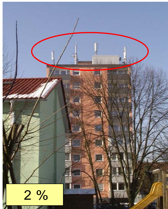
Abb. 7.3: Ergebnis einer Immissionsmessung im Außenbereich eines Kindergartens, der sich in 80 Meter Abstand zu einem Mobilfunkstandort befindet.
