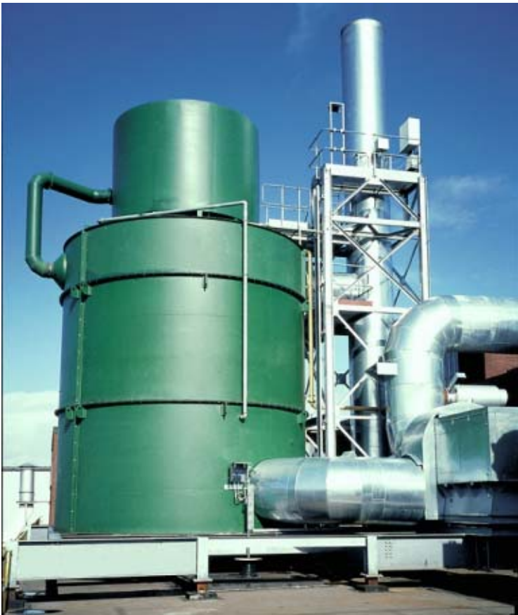
Abb. 5: Diese RNV, Nennleistung 23.000 Nm 3 /h, arbeitet bei der Abluftentsorgung aus der Kunststofflackierung weitgehend autotherm („Fotos EISENMANN“)
