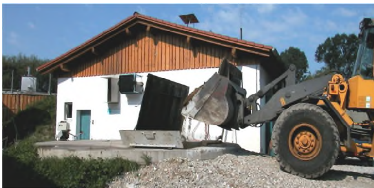
Abbildung 20: Abgedeckte Vorgrube zur Güllezwischenlagerung und Zumischung von Feststoffen ((LfL, 2007)
