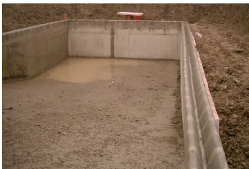
Abbildung 18: Entleertes (links) und aktiver Fermenter (rechts) einer Anlage zur Feststoffvergärung im Grubenverfahren (LfL, 2007)
