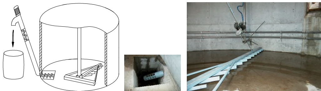
Abbildung 23: Bodenräumer zum Austrag von Schwerstoffen (Mitte: Austragsschnecke) - (LfL, 2007)
