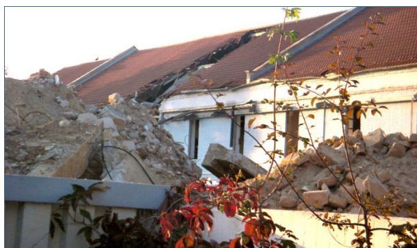
Abb. 19, 20: Ein Abbruch ganzer Häuser mit dem Bagger führt zu Gemischen mineralischer Abfälle, aus denen in der Regel nichts Hochwertiges mehr hergestellt werden kann.
