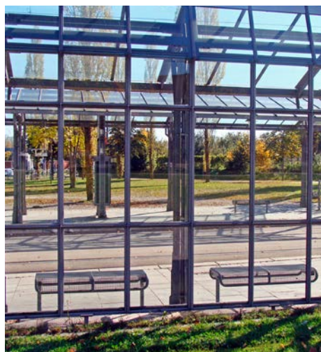
Abb. 8 und 9: Transparente Durchsichten wie bei Treppenaufgängen (links) oder Wartehäuschen (rechts) führen zu häufigen Kollisionen, weil Vögel direkt auf ihr Ziel zufliegen und dabei gegen die Scheiben prallen.
