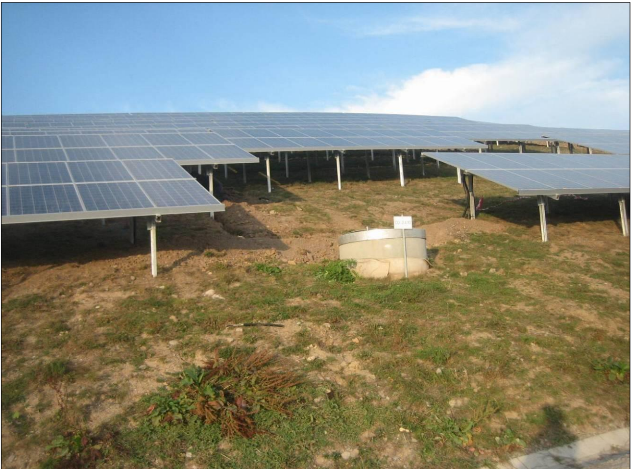
Abb. 1: Beispiel einer Reihenaufstellung mit großen Montagepulten
