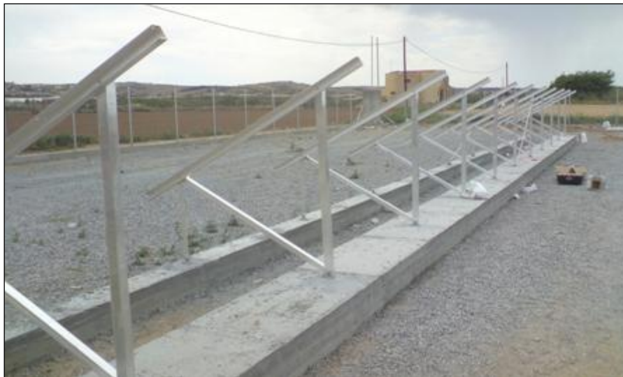
Abb. 4: Beispiel Betonfundament (Anordnung längs oder quer)
