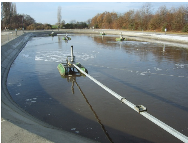
Abb. 7: Beispiel einer Abwasserteichanlage mit technischer Zwischenstufe
