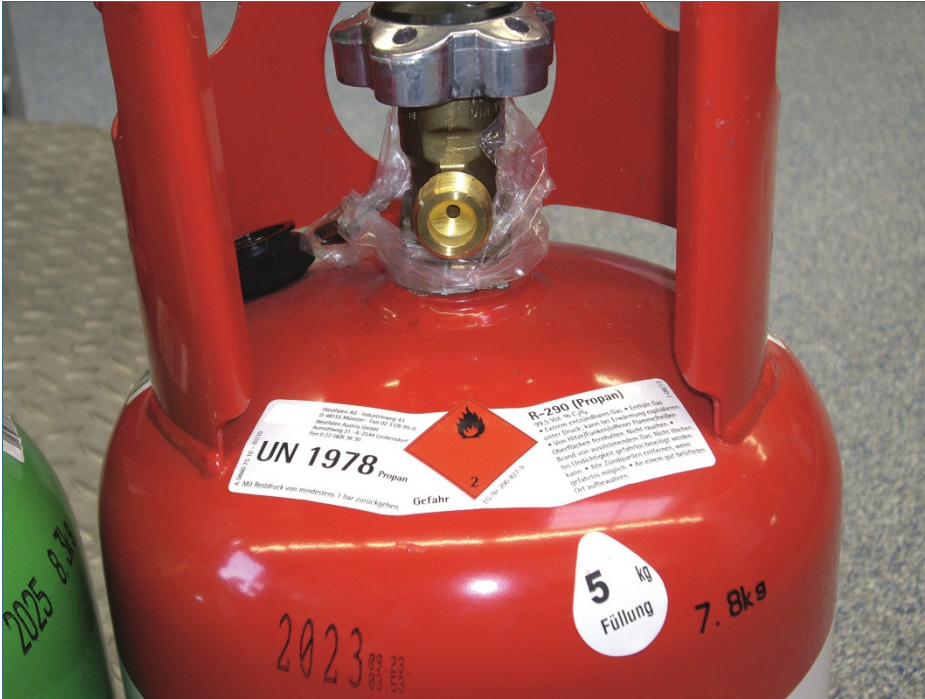
Abb. 5: Kältemittelbehälter mit dem natürlichen Kältemittel Propan
