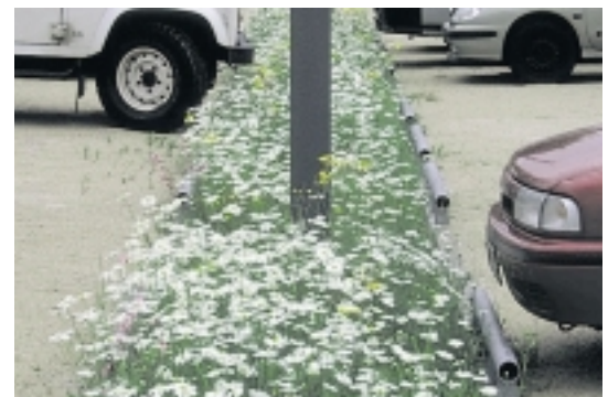
Abb. 18: Versickerungsmulde im Parkplatzbereich
