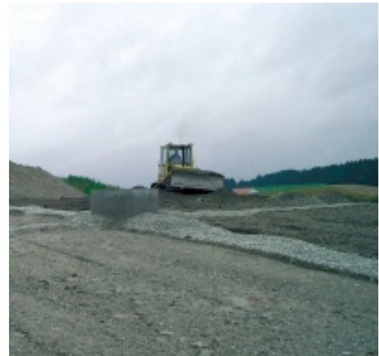
Abb. 9: Errichtung einer Gasdränschicht
