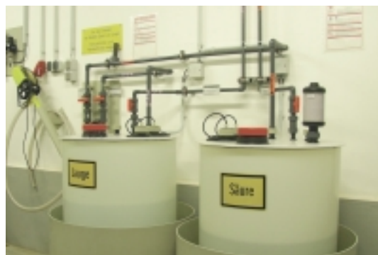
Abb. 21: Neutralisationsanlage
