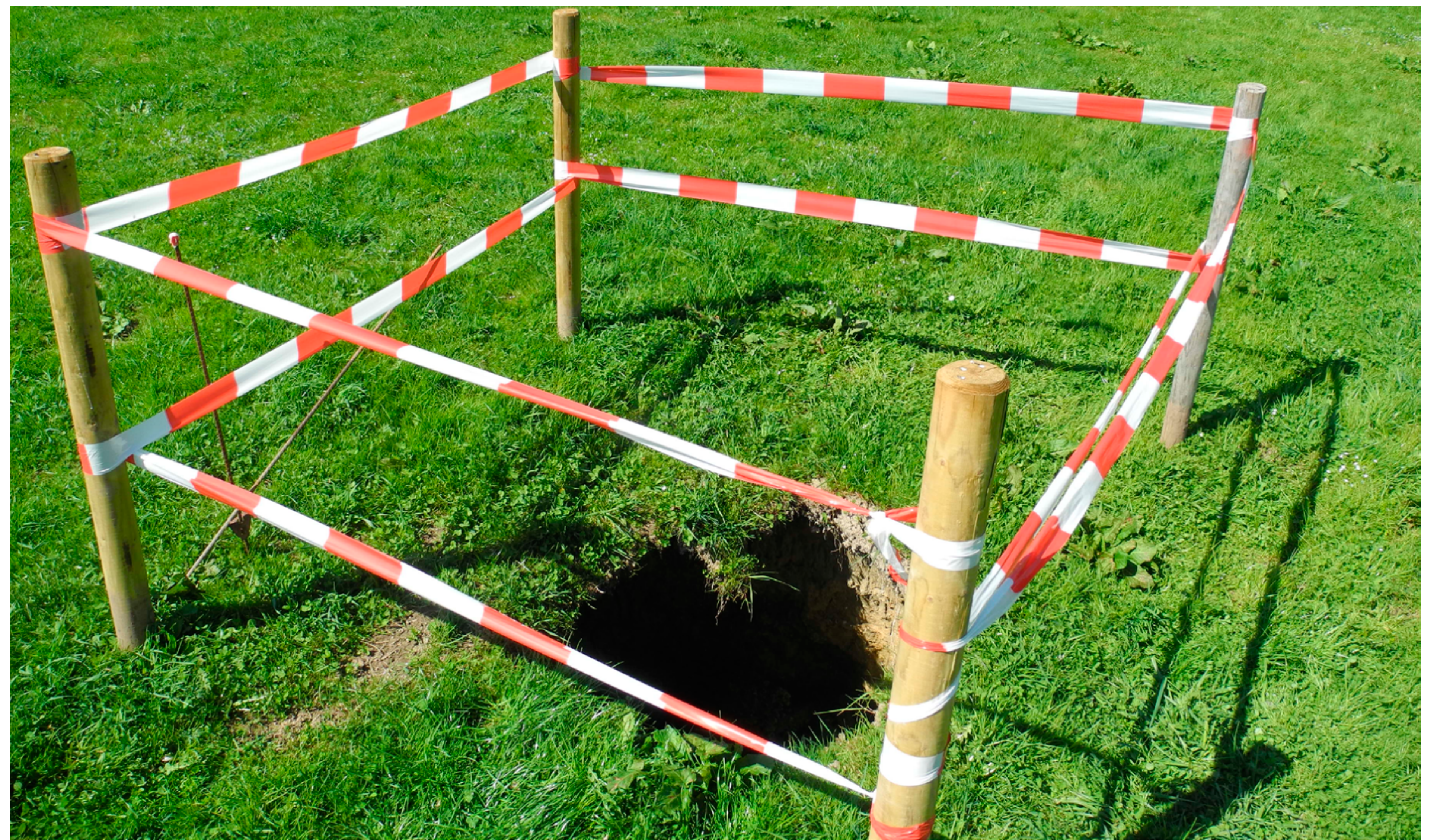
Erdfall bei Traunstein 2015: Die Struktur erweiterte sich glockenförmig nach unten.
