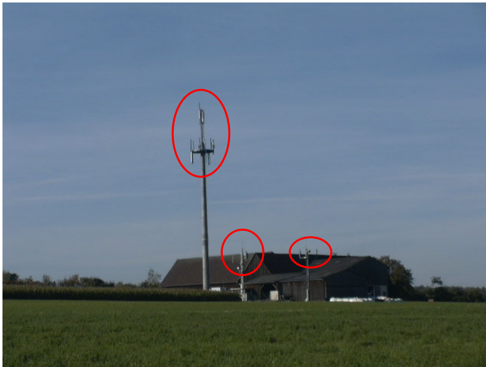
Abb. 6.4: Unterschiedliche Montagehöhe von Mobilfunkantennen (Beispiel).
