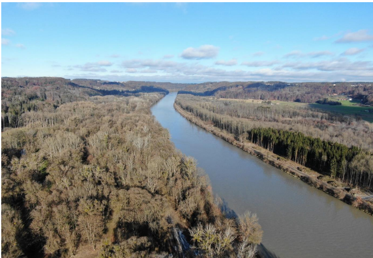
Abb. 9: Die Ufer der hier noch stark eingegengten Salzach bei Tittmoning sollen im Laufe der nächsten Jahre ausgeweitet und das Flussbett deutlich verbreitert werden. Foto: LfU, M. Mitterbacher
