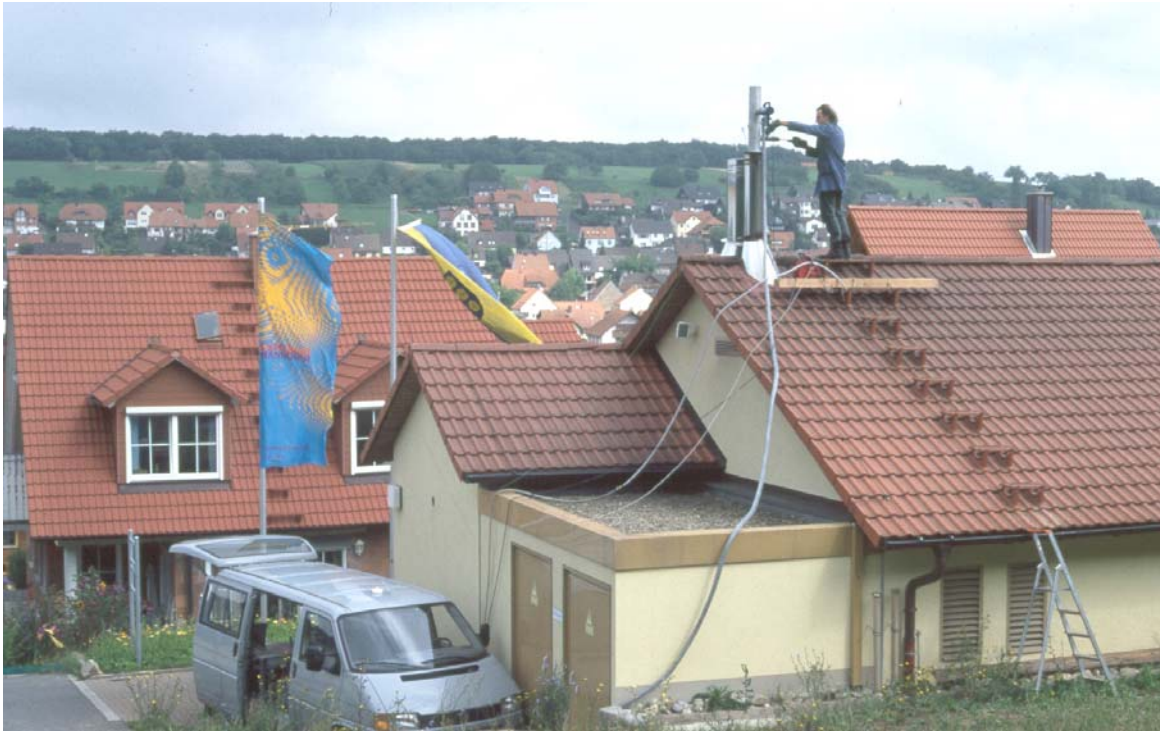
Abbildung 11: Gebäude des BHKW Greußenheim bei den wiederkehrenden Emissionsmessungen mit Messbus
