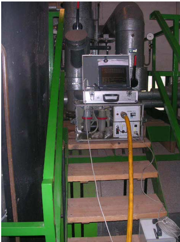
Bild 6.3-2: Gravimetrisches Stabmessgerät Gravimat SH5 im Einsatz vor Ort
