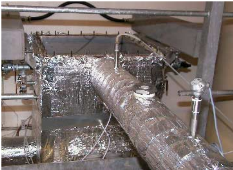
Bild 4.1-2: Versuchsabscheider mit geöffnetem Reingasraum und Reingasmessstrecke
