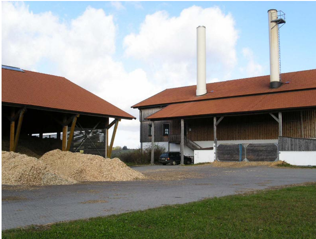
Bild 2.4-1: Heizhaus des Kurbetriebes Sibyllenbad
