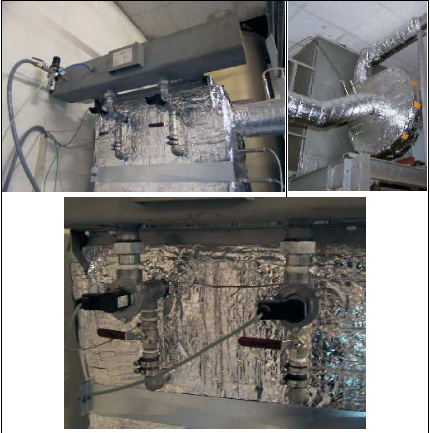
Bild 4.1-4: Versuchsabscheider, Regenerierungssystem, Ventilator
