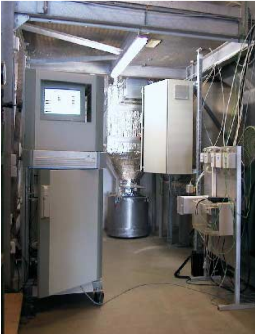
Bild 4.1-5: Versuchsabscheider mit Staubbunker, Schaltschrank und kontinuierlicher Betriebsmesstechnik
