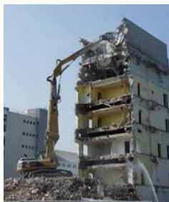
Gezielter Rückbau eines Gebäudes nach Rückbaukonzept
