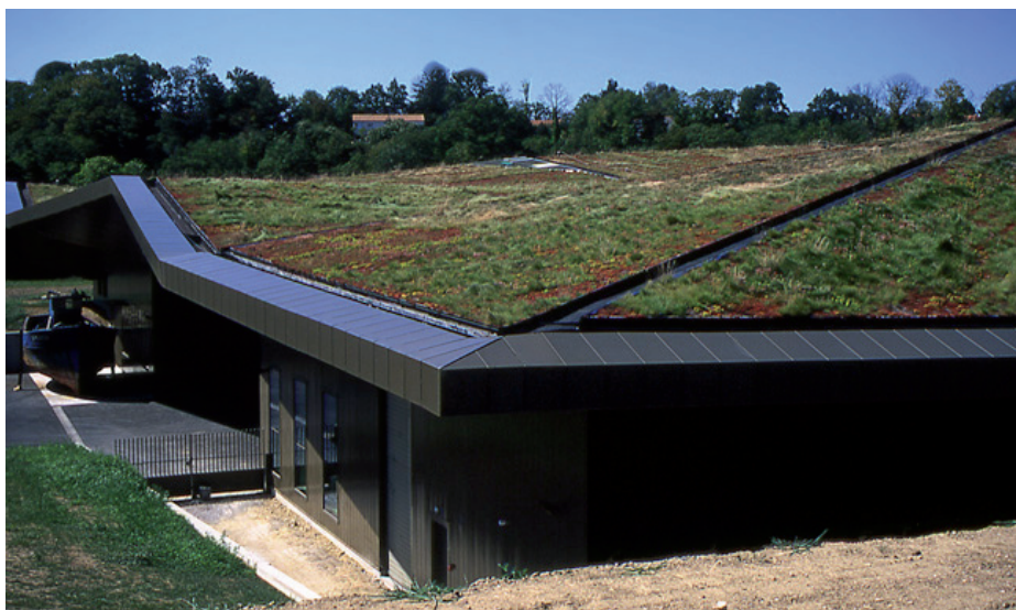
Abb. 4: Mit einem Gründach lassen sich bis zu 70 % des anfallenden Niederschlags zurückhalten
