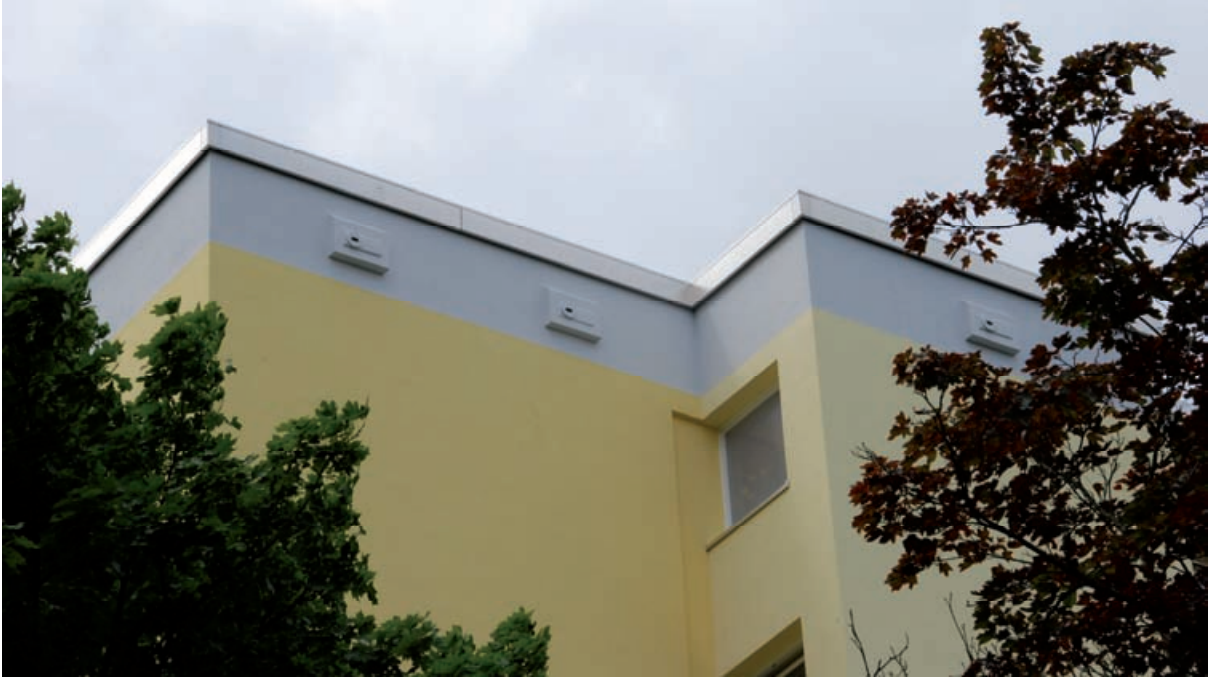
Abb. 2: Ersatzmaßnahme (teilintegrierte Nistkästen) für Mauersegler an einem Gebäude in München
